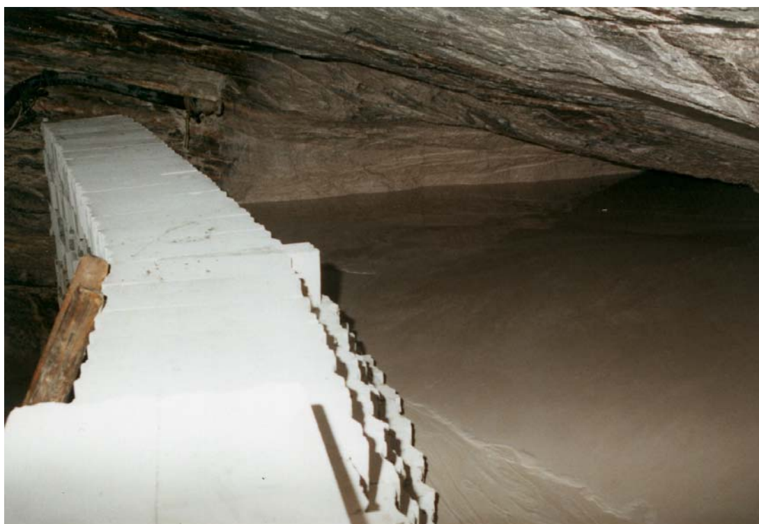
Bild 1 - Einbau einer dauerplastischen Barriere in einer Strecke im Bergwerk Bischofferode
