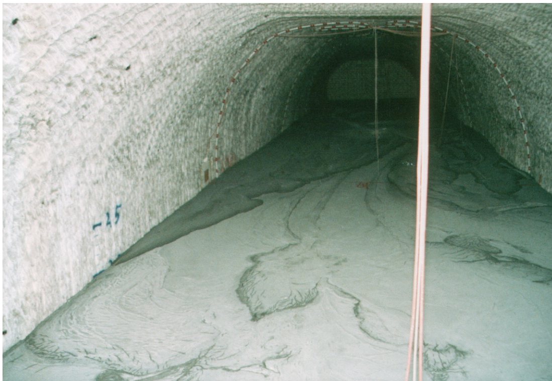
Bild 2 – Errichtung einer Strömungsbarriere auf dem Forschungsbergwerk Asse
