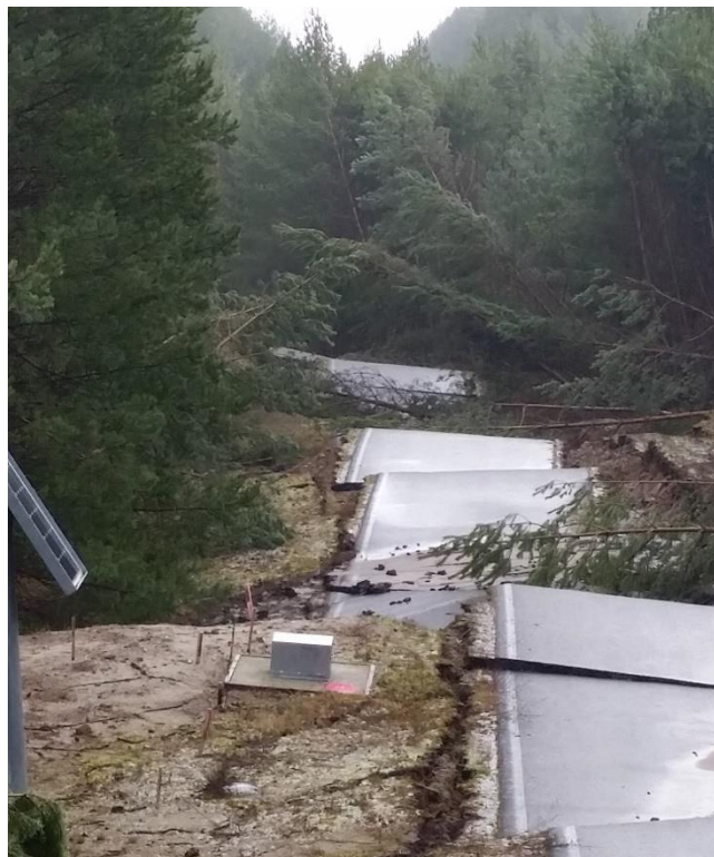
Abb. 1: Verflüssigungsereignis vom 18.12.2017; Straße über Innenkippe Schlabendorf-Süd zeigt deutliche Staffelbrüche; betroffene Fläche: 39,8 ha
